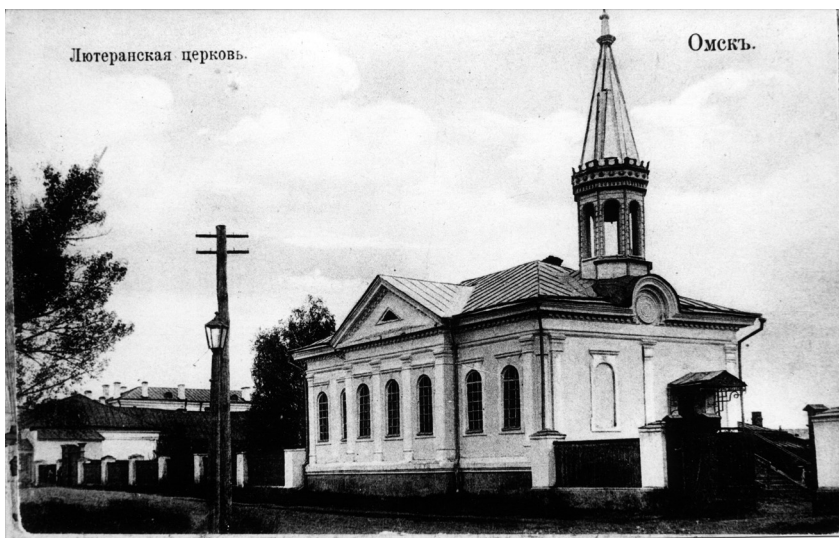
Лютеранская церковь – кирха
